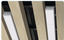
МОНТАЖ В РЕЕЧНЫЙ ПОТОЛОК
